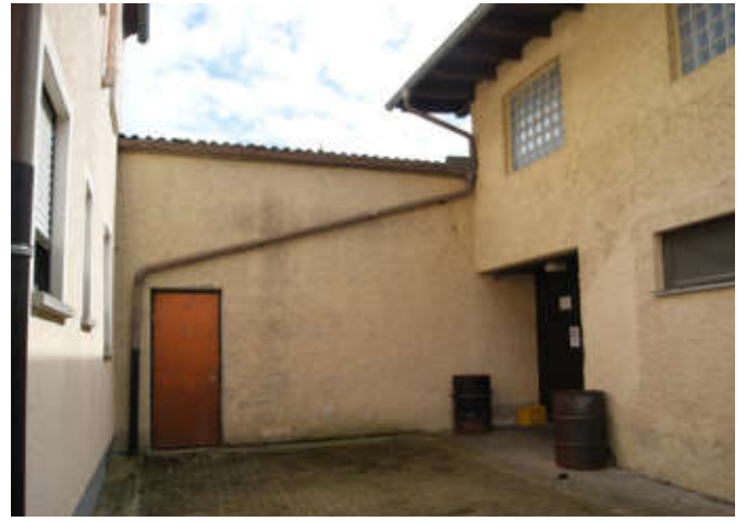
ehemaliger Haupteingang (rechts im Bild) für den Diskotheken-Betrieb 06
