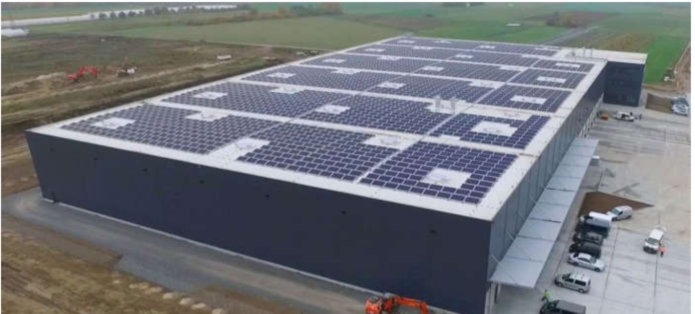
Solarenergie und Photovoltaik in Röthlein 02
