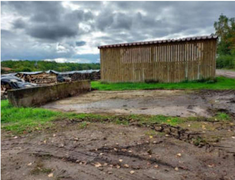
Landw. Halle auf dem Plangelände Maßnahme 15
