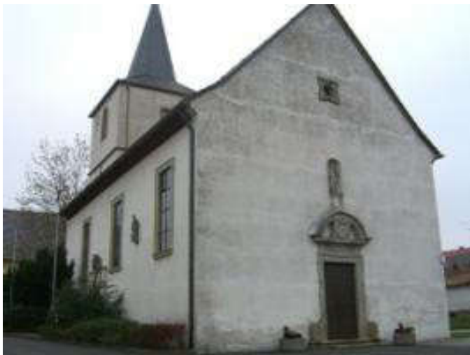
Außenansicht der Kirche St. Kilian 06
