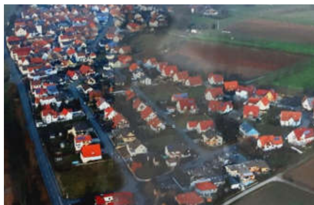
Siedlungsstruktur und Dachlandschaft Hirschfeld 06
